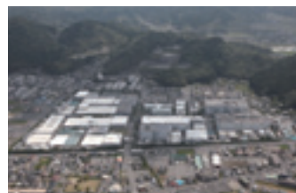
鹿児島国分工場 Kagoshima Kokubu Plant
