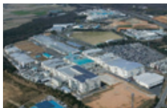
滋賀八日市工場 Shiga Yohkaichi Plant
